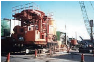
掘削土再利用地中壁現場
