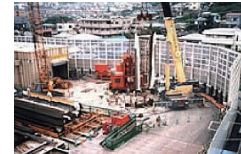
地中連続壁施工現場
