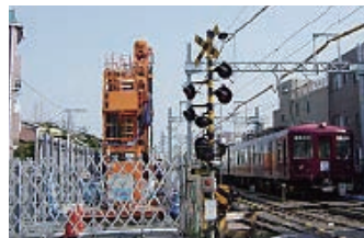
TMW山留連続壁工法 [鉄道地下化工事]
