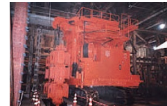
MRD-200による路下施工
