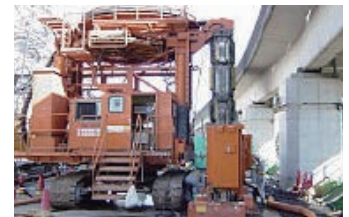
EMX山留連続壁工事 [共同溝工事]
