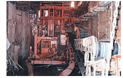
TBH掘削機による導坑内施工
