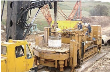
アルジェリア民主人民共和国 高速道路の基礎杭工事
