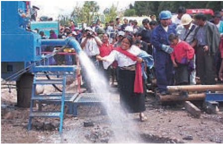
エクアドル共和国 井戸掘削、共同水栓施設建設
